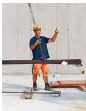
Regola 3 Imbracare correttamente i carichi.
