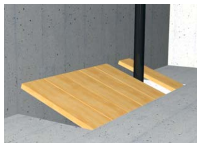
Piccola apertura nei pressi di una parete, con tavole incuneate
