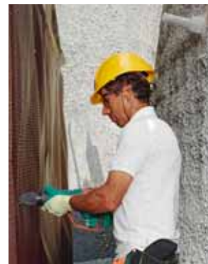
Regola 8 Mettere in sicurezza gli scavi.
